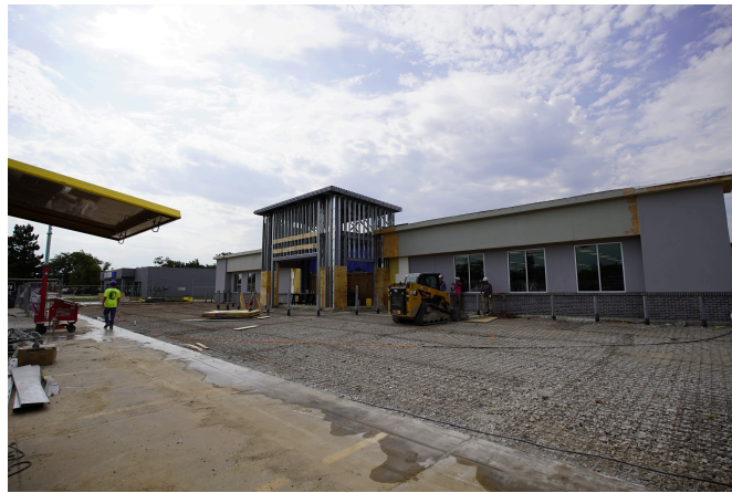
Vestíbulo del edificio en la calle W. Central en construcción (foto cortesía de Dondlinger Construction)
